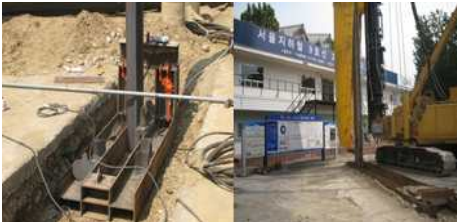
<그림 6> 기준틀 시공전경
