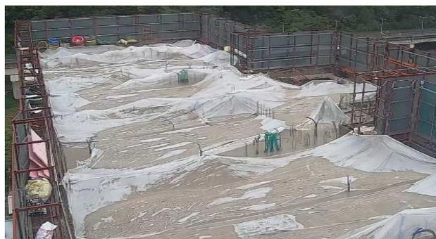
그림 3-12. 콘크리트 타설부위 비닐시트 보호 예시
