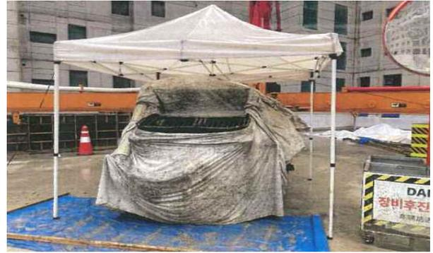
그림 3-11. 펌프카 호퍼외부 천막 설치 예시
