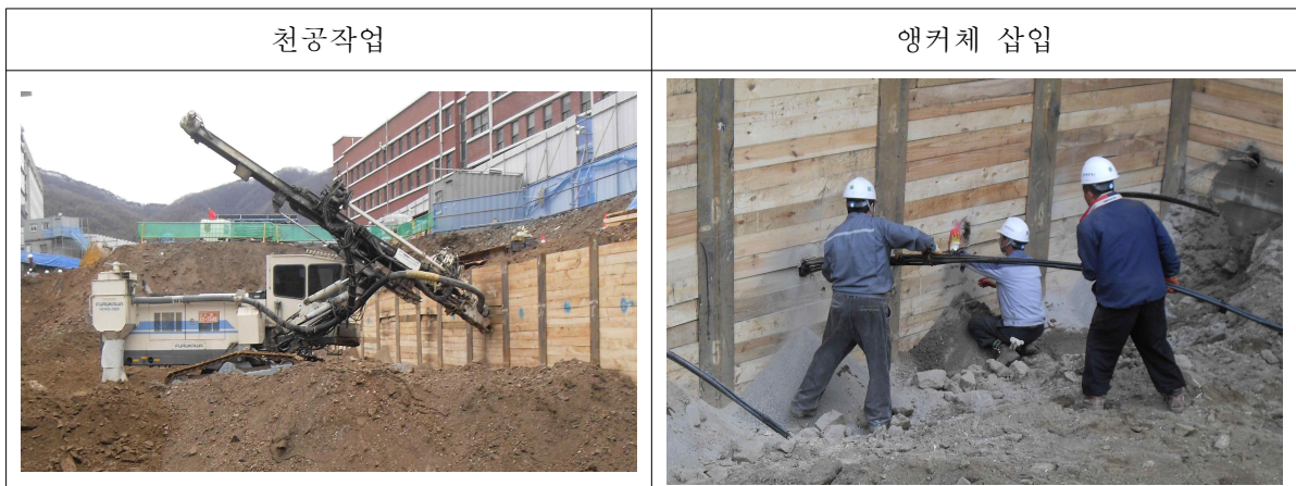
<그림 2> 어스앵커 공사의 작업내용 및 순서
