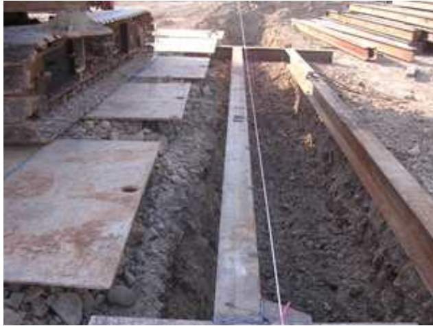
<그림 4> 안내벽의 시공 후 전경
