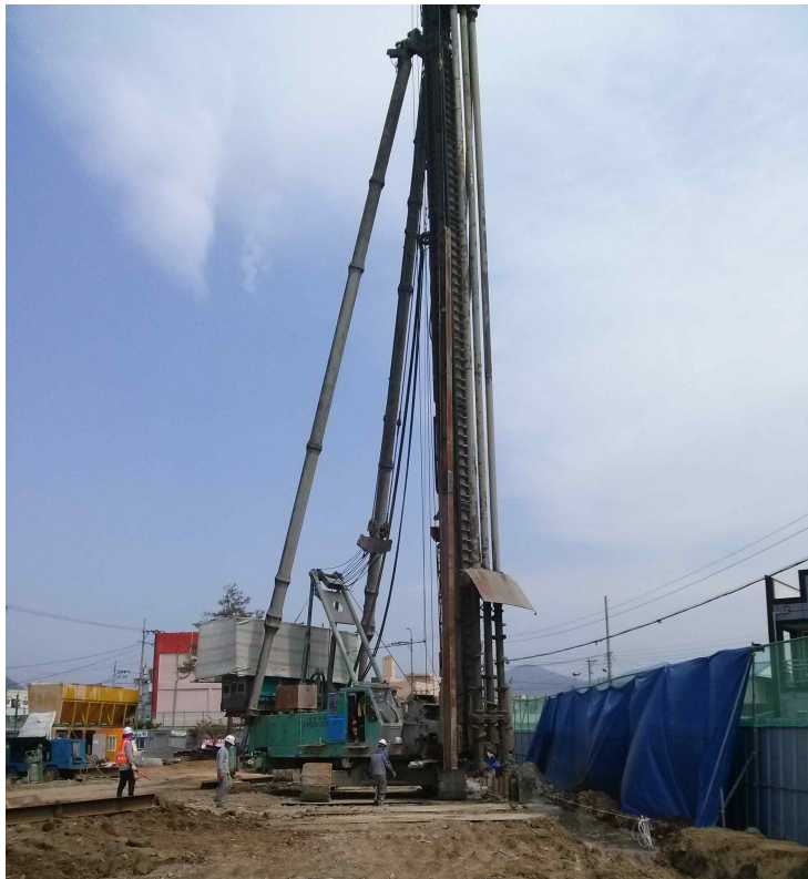
<그림 6> 크롤러형 시공기의 리더 설치
