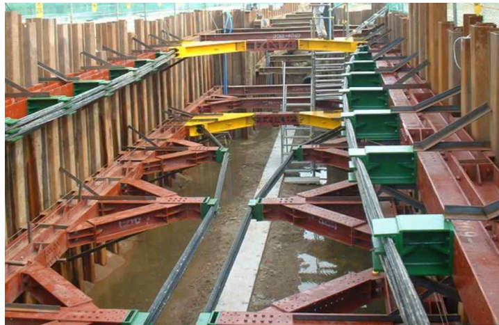
<그림 7> 띠장의 PS 강선 긴장작업 완료
