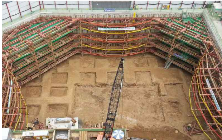
<그림 9> 띠장 긴장 공법 흠막이 공사 전경
