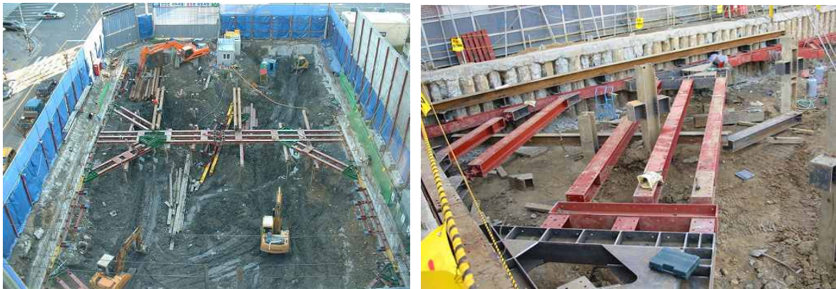
<그림 3> 띠장 및 중앙·코너부 버팀보 설치
